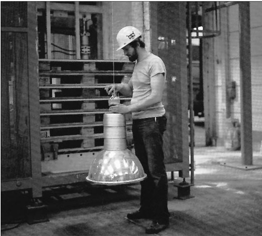
Figura 6.2: diminuzione dei costi di manutenzione mediante un sistema di cavi flessibili (fonte: Hellux)
