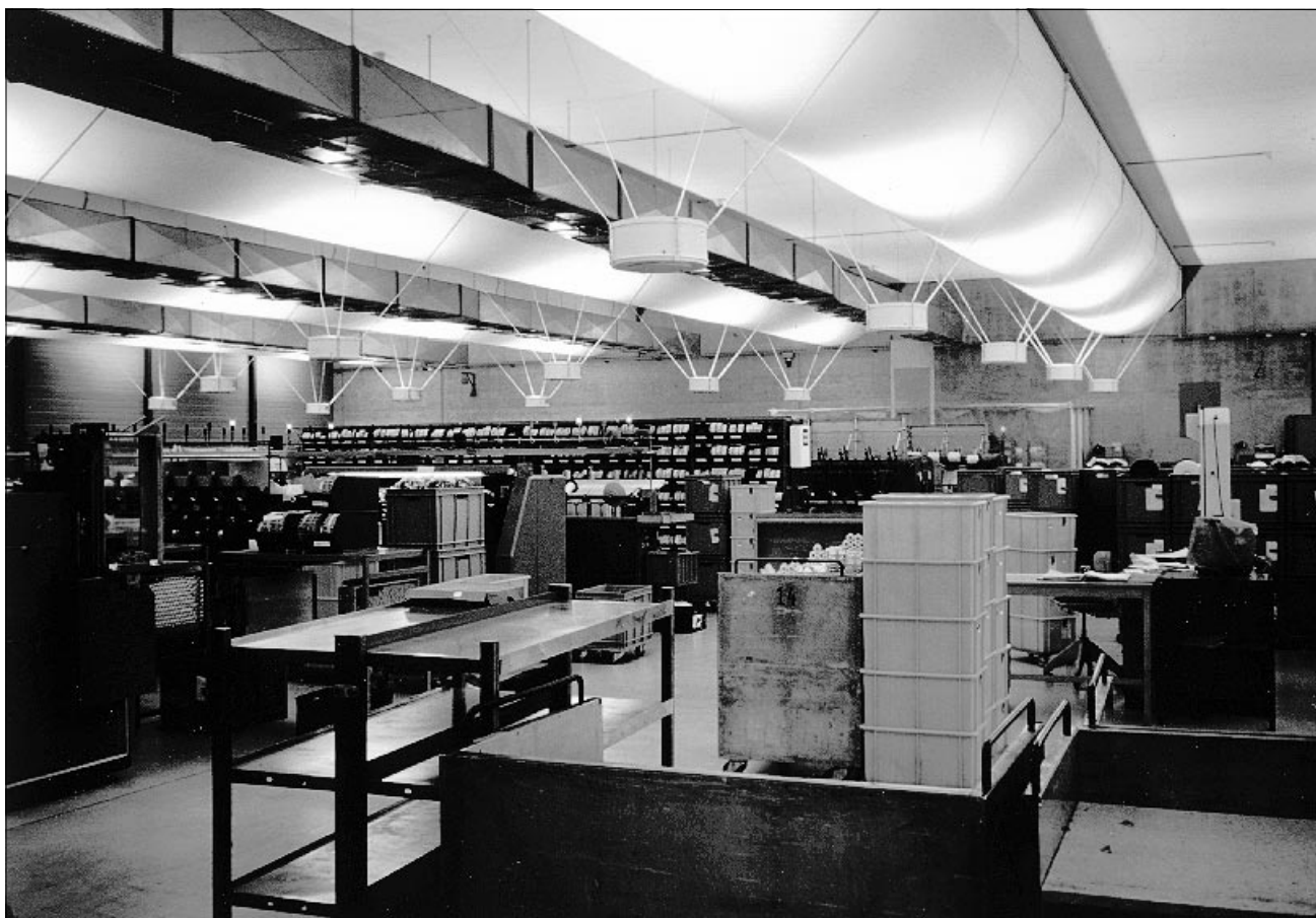
Figura 2.7: impianto d'illuminazione variante 2
